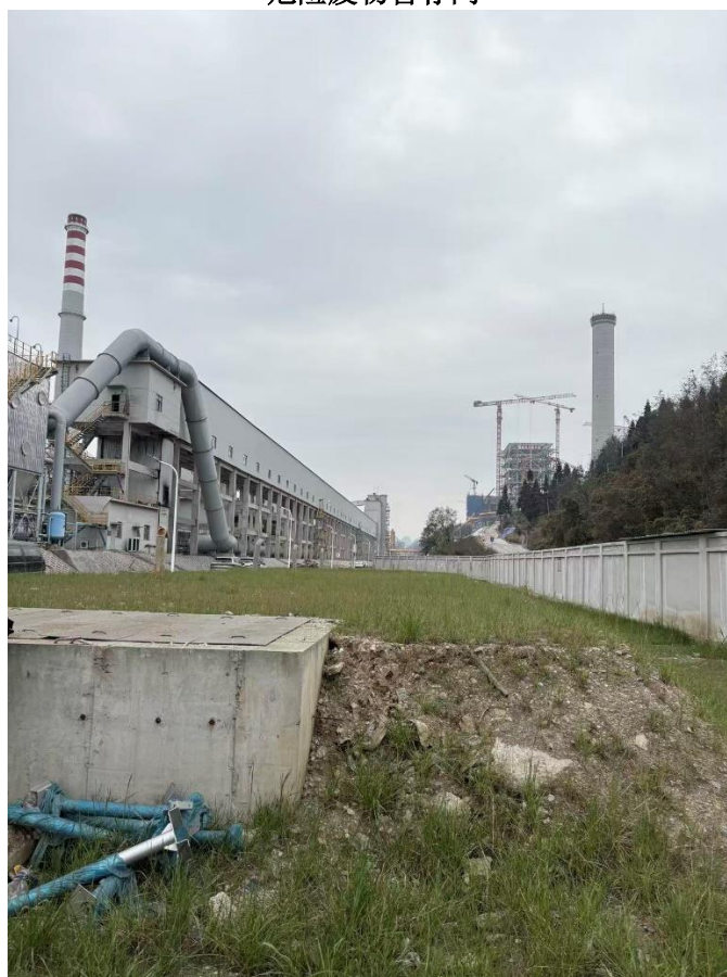
初期雨水收集池
