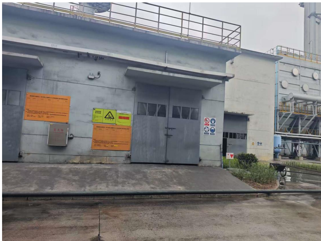
危险废物暂存间
